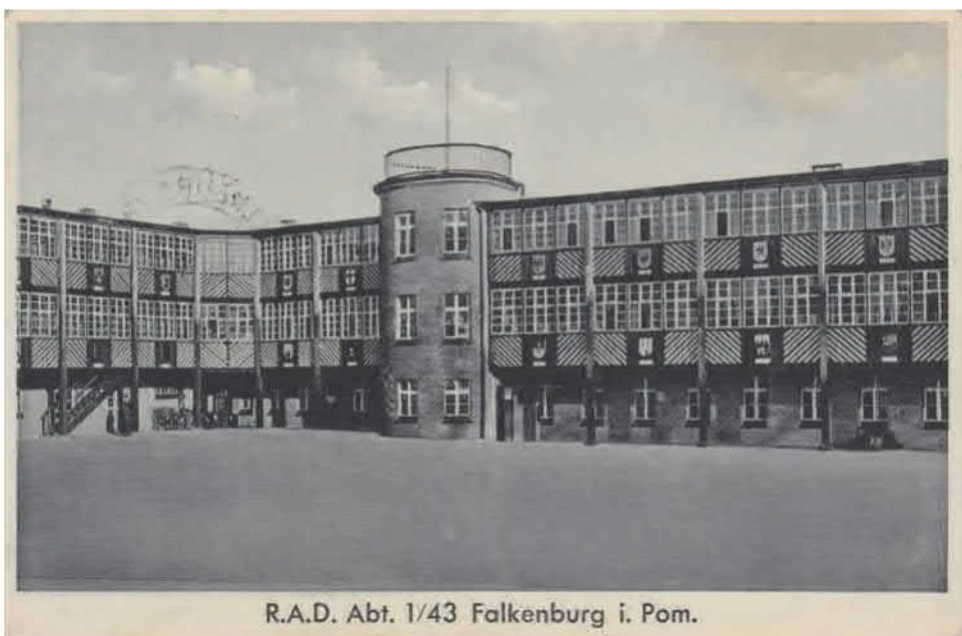
Koszary oddziału Służby Pracy. Dziś budynek mieszkalny. Źródło: www.pojezierzedrawskie.info
